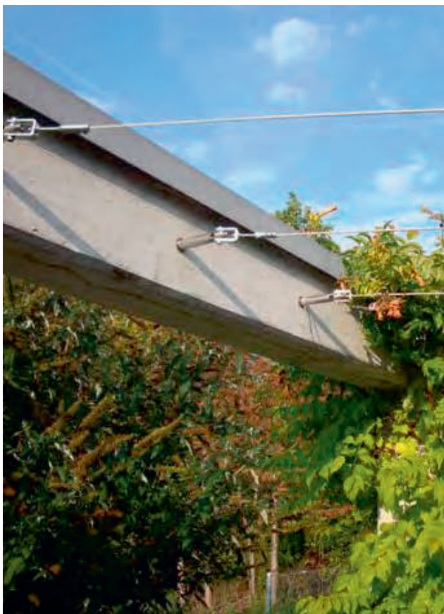
Pergola in Betonrahmen (Seile straff gespannt)
