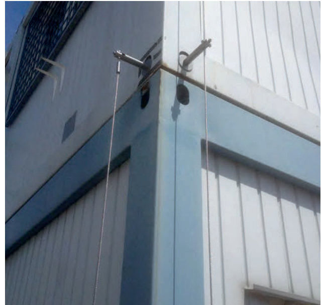
Spezialbefestigung in Container-Aufnahme
