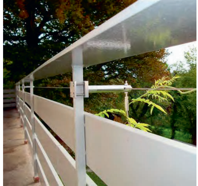
Befestigung am bestehenden Balkonpfosten
