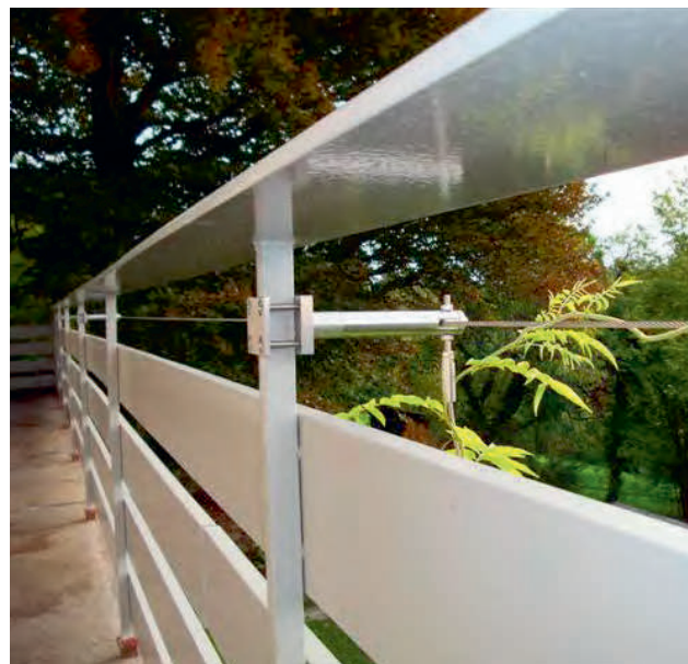
Fixation au poteau de balcon existant
