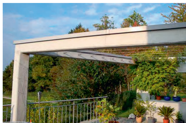
Tendeur de câble KletterMax directement dans la construction
