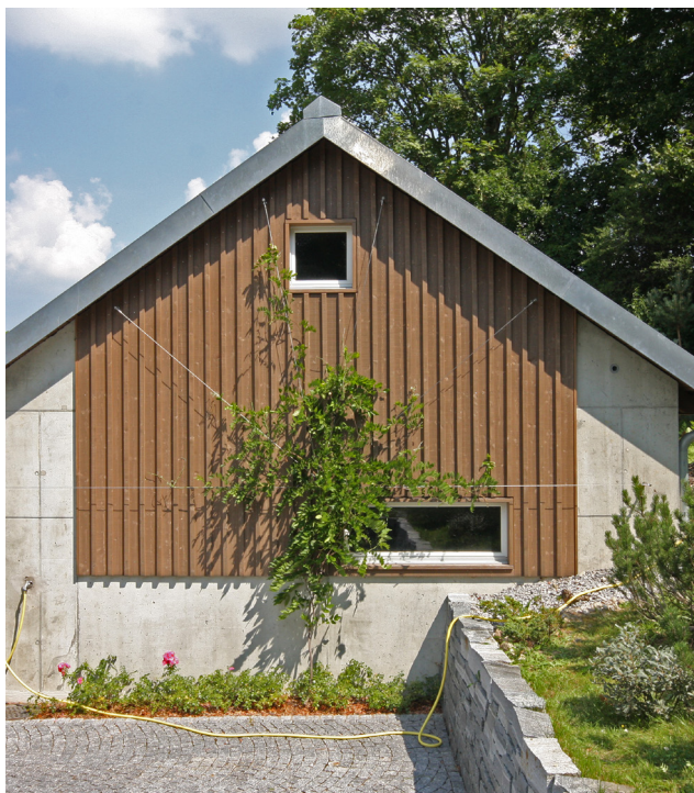
Combinaison béton et bois
