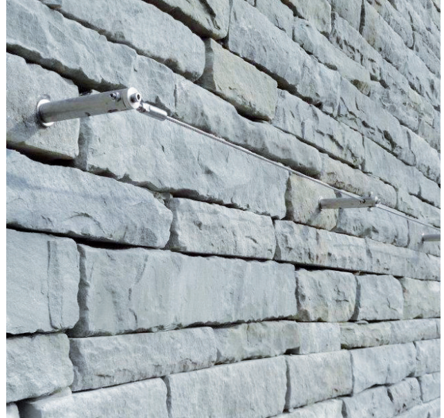
Mur en pierres sèches
