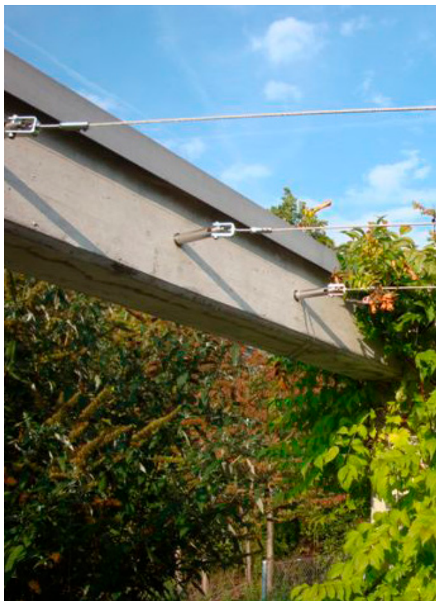
Pergola en cadre de béton (câbles tendus)
