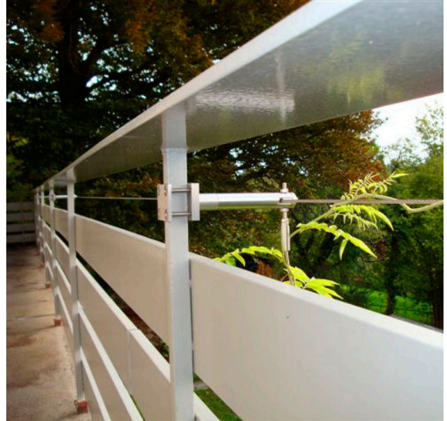
Fixation au poteau de balcon existant
