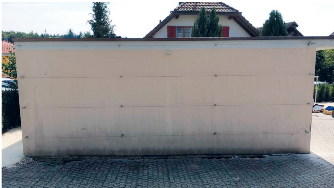
Directement après le montage
