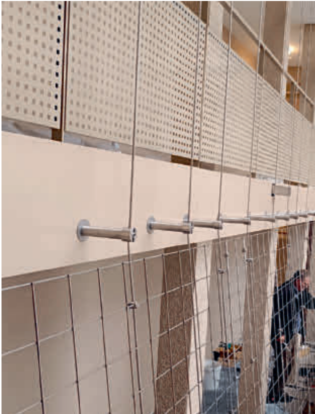
Kombination Begrünung und Absturzsicherung
