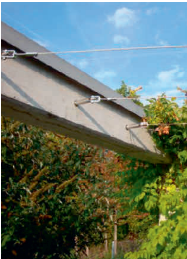
Pergola in Betonrahmen (Seile straff gespannt)
