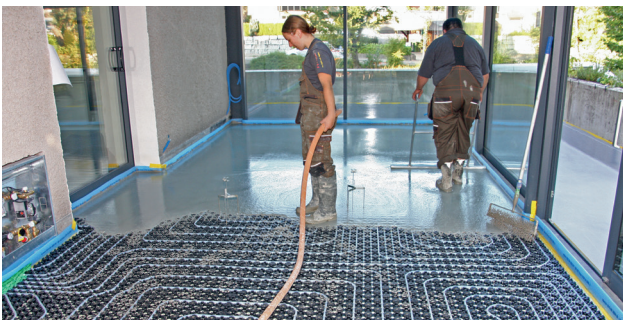
Le PCI Anhydrit est introduit.
