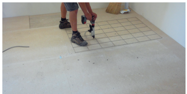
Visser la deuxième couche (avec grille) repousser l'excès de colle, affleurer proprement les vis saillantes.
