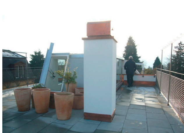
Terrasse de toit terminée
