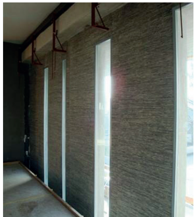
Construction murale terminée avec papier peint en bambou.
