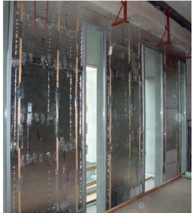
Plaques isolantes Vakutherm avec sous-construction.
