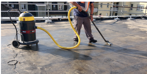
Il faut au préalable passer l'aspirateur sur le sol ...
