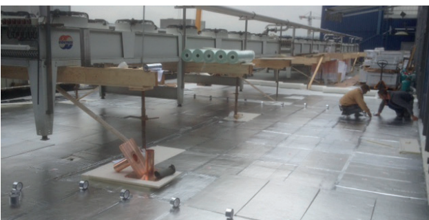
Pousser les Vakutherm les uns vers les autres et coller.
