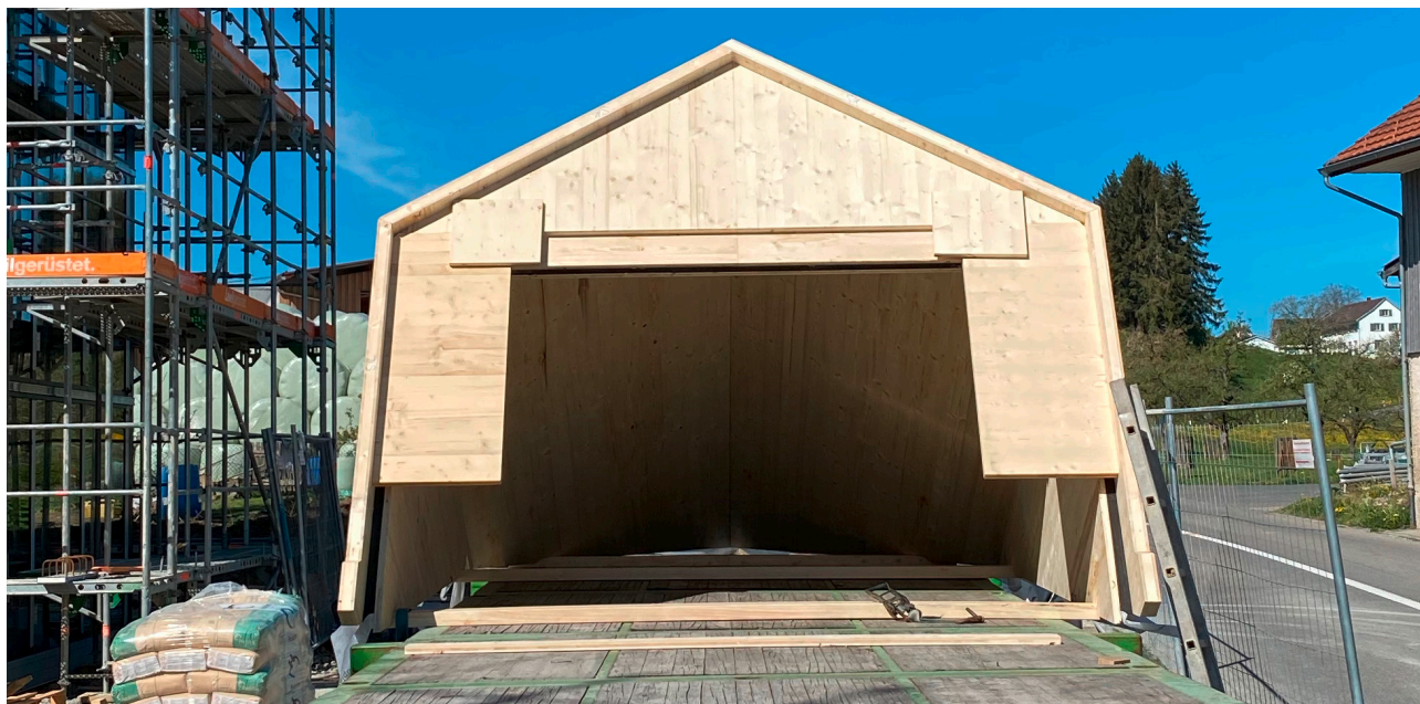
Lucarne préfabriquée sur support
