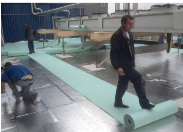
Pose du non-tissé de protection vert, 1 mm
