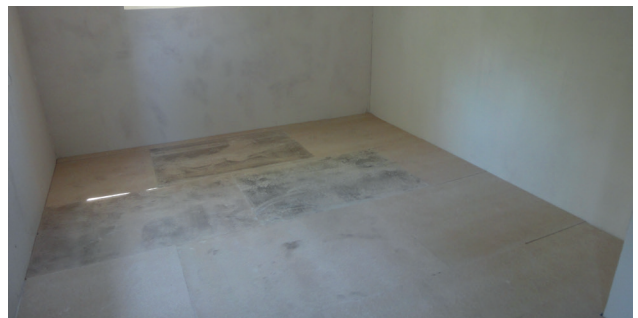
Poser une première couche de Rigidur (pas de joints croisés).
