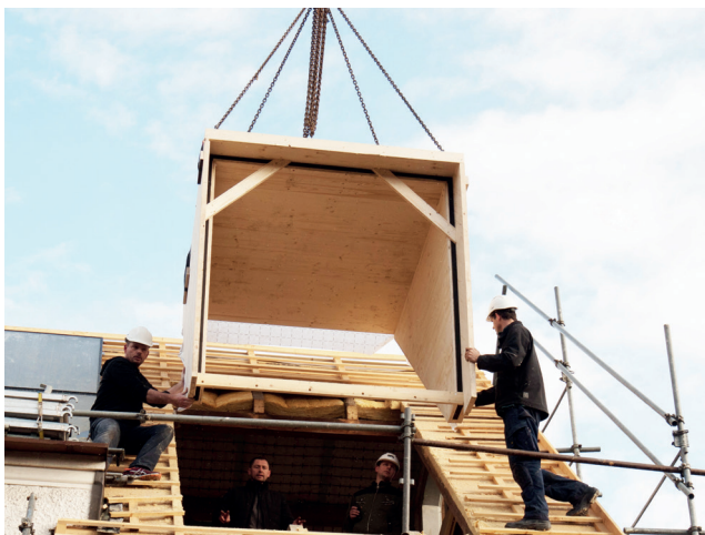
Déplacement de la lucarne peu encombrante
