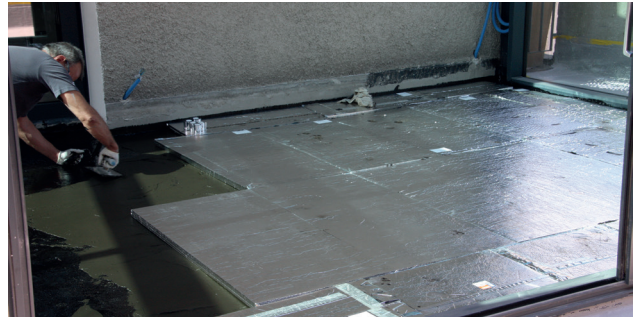
Les plaques Vakutherm sont posées dans l'ISO-Sealtec HBB encore liquide si bien qu'elles adhèrent au fond.
