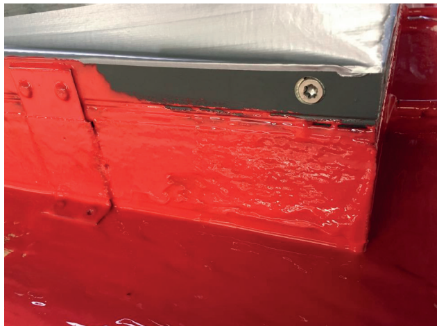
Étanchéité avec ISO-Sealtec MS-PU, raccordement à une lucarne
