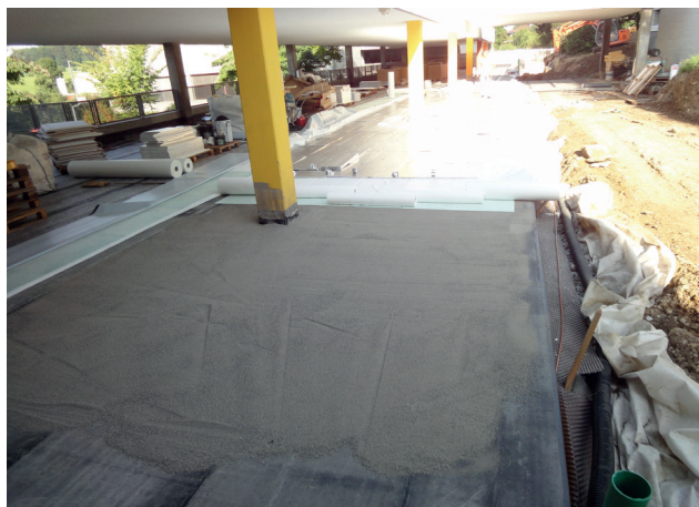
Correction fine avec sable de compensation
