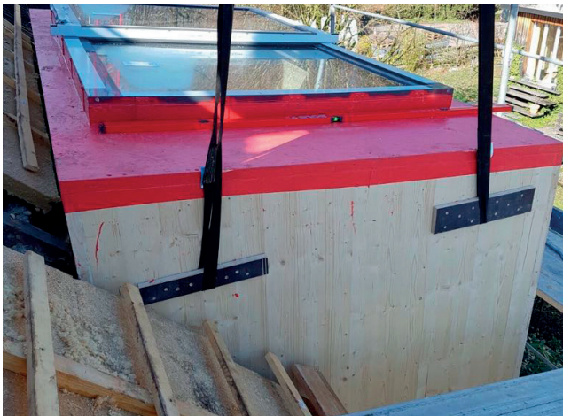
Raccordement de salle d'eau à une maison existante
