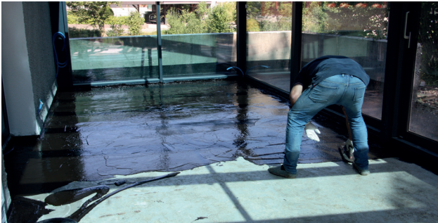
Toute la surface est enduite d'ISO-Sealtec HBB pour l'étanchéifier.
