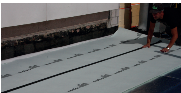
Le non-tissé vert est posé comme deuxième couche protectrice.
