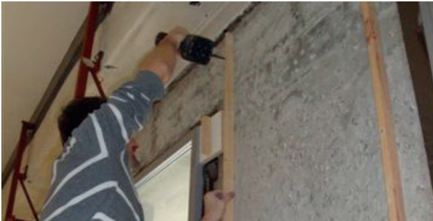
Installation de la sous-construction.
