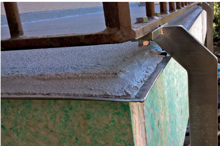
Détail de la construction d'angle de garde-corps
