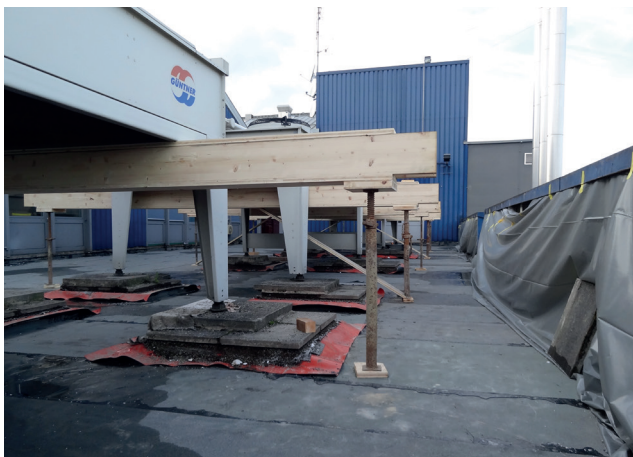
Levage des groupes frigorifiques jusqu'à 12 000 kg
