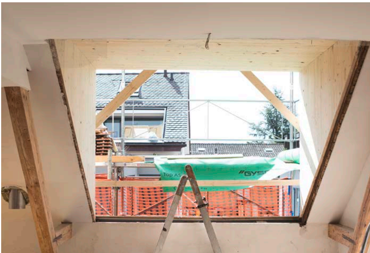
Vue de l'intérieur vers l'extérieur, lucarne posée
