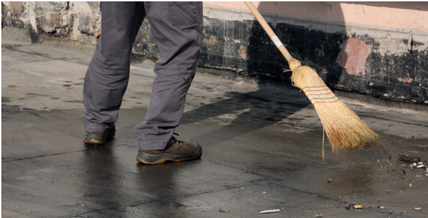
Nettoyer et sécher le sol.
