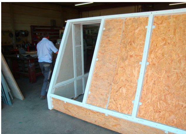
Châssis de la sortie de toit, gros œuvre
