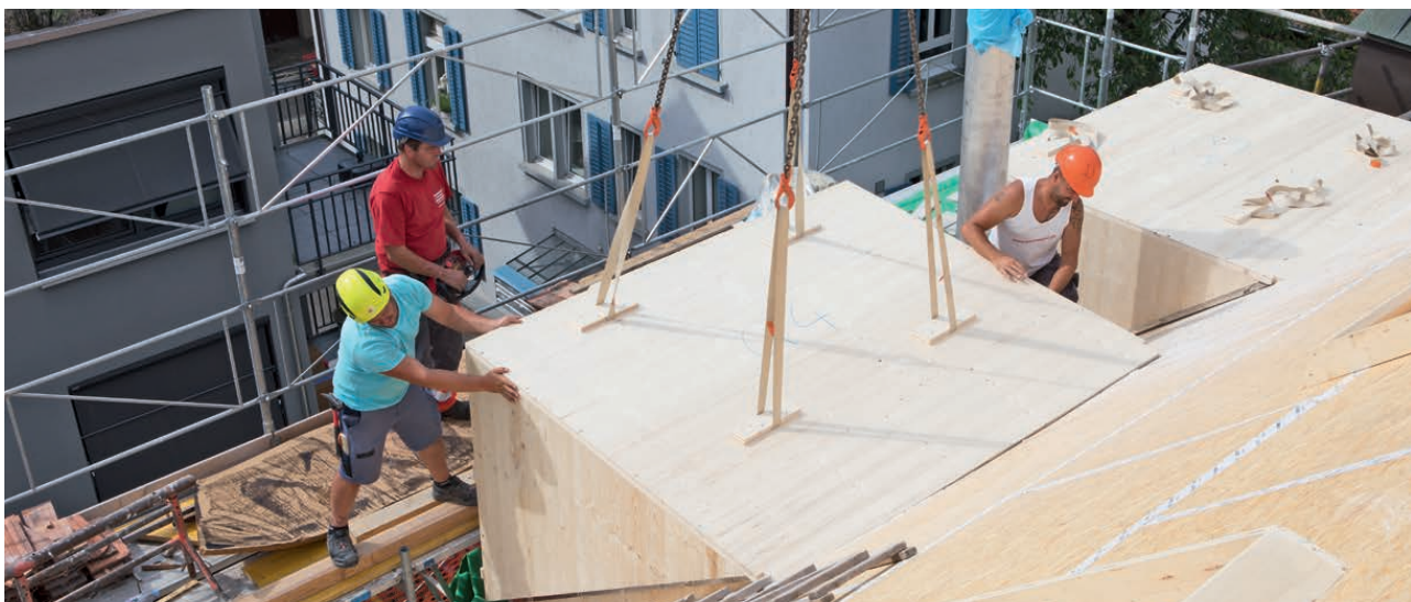
La lucarne est positionnée correctement puis fixée
