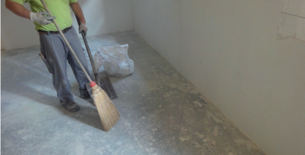
Nettoyer et sécher le sol.
