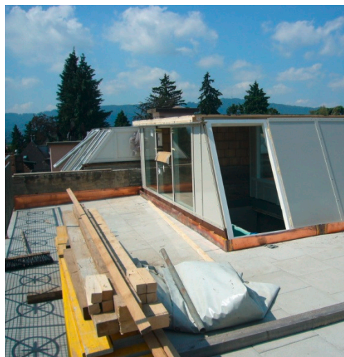
Plaques isolantes Vakutherm adaptées sur mesure
