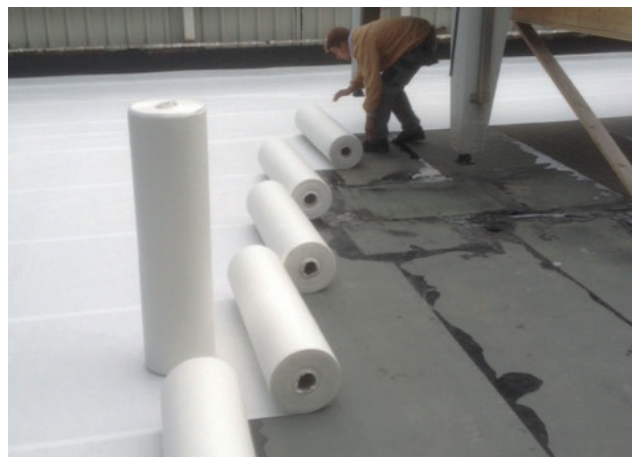
Pose du non-tissé de protection blanc, 1 mm
