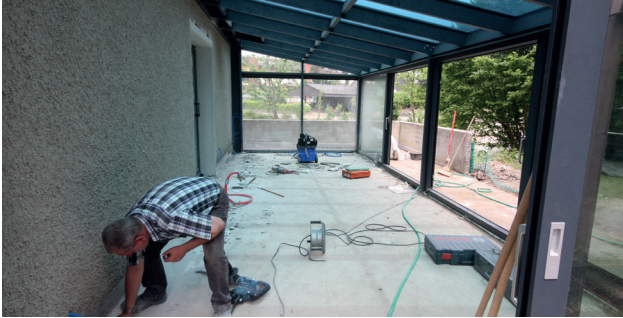
Le sol doit au préalable être exempt d'aspérités.
