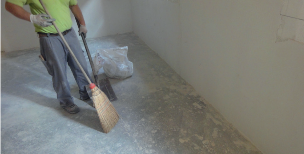
Nettoyer et sécher le sol.
