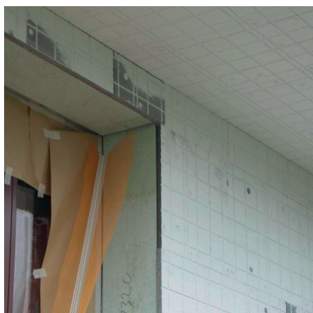
Embrasure de fenêtre Polyton Compact et EPS
