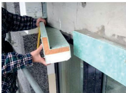
Lintheau, caisson de volet roulant
