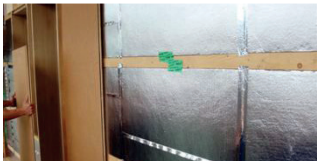
Sous-construction de façade
