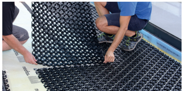
Le système Uponor-Minitec est collé sur le non-tissé.
