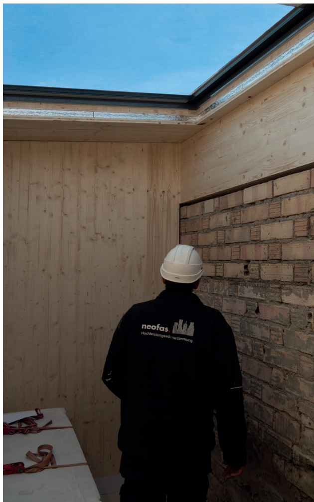
Déplacement de salle d'eau avec une grue
