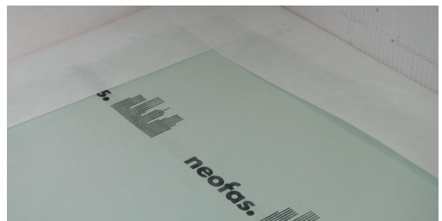
Poser le voile de protection incendie sur le non-tissé blanc.
