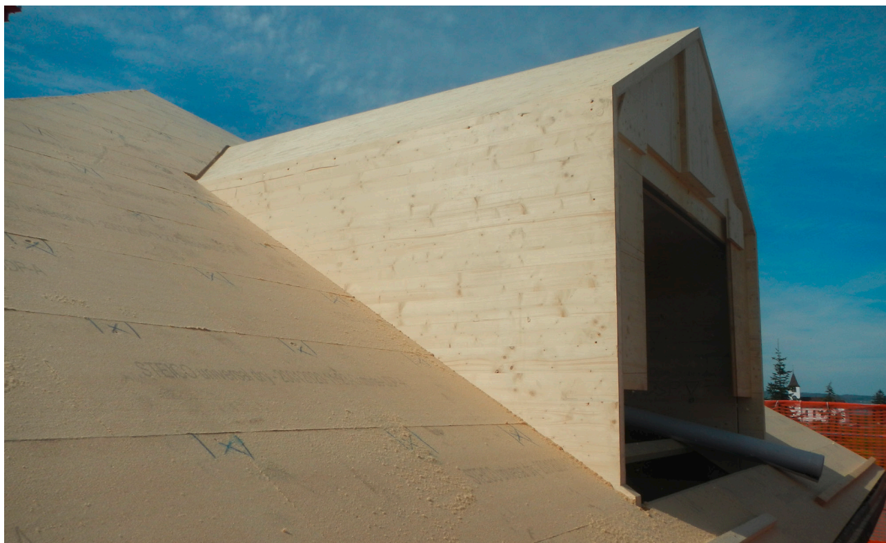
Pose sur toiture
