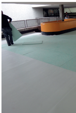
Pose et collage des plaques de pression
