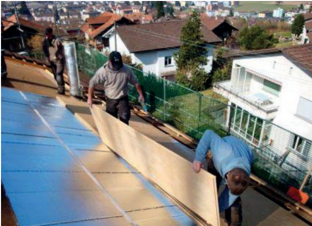
Collage des panneaux de fibres.
