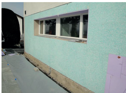
Paroi extérieure de la cave avec fenêtre
