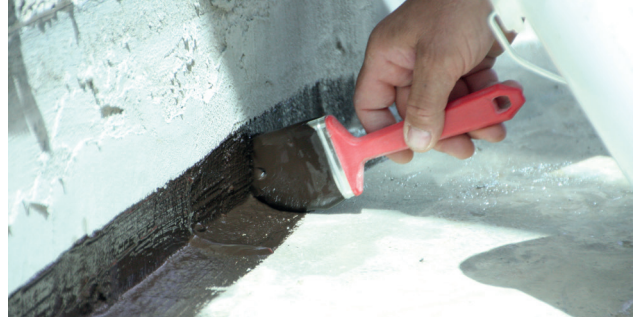
Tous les raccordements muraux/au sol sont enduit d'ISO-Sealtec HBB pour assurer la meilleure étanchéité possible.
