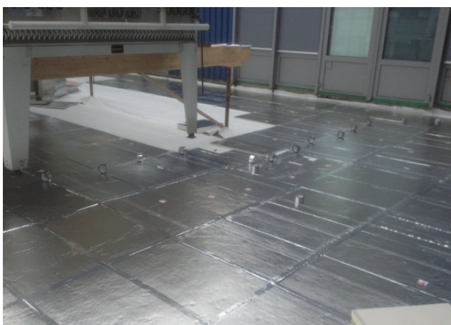
Pose première couche de Vakutherm
