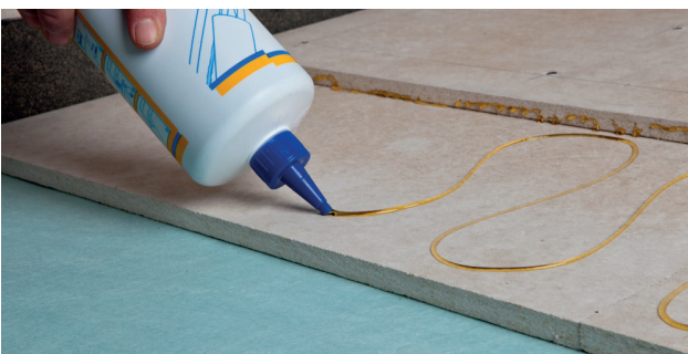
Poser une deuxième couche de Rigidur et la coller avec la première (déplacer les raccords).
