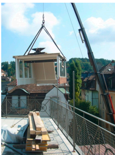
Montage de la sortie de toit
