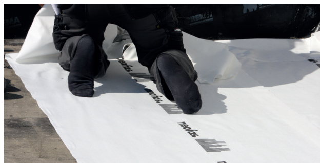
Le non-tissé blanc est posé et relevé sur le mur.
