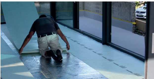
Un non-tissé adhésif simple face vert est posé sur Vakutherm. Les raccords du non-tissé sont collés avec du ruban adhésif noir.
