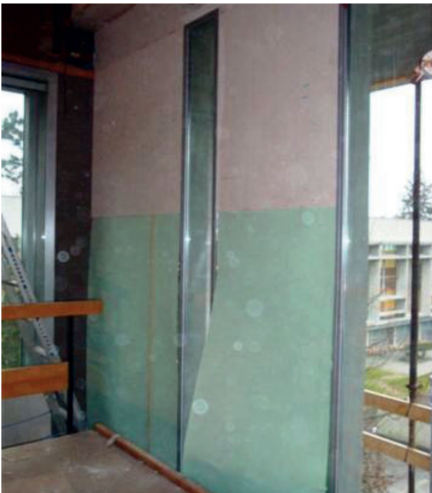
Non-tissé de protection et plaques de support.
