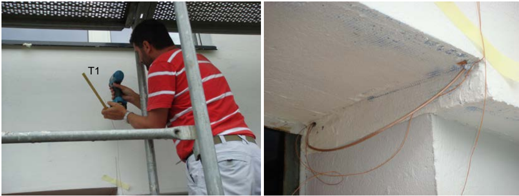
Figur 10: Montage der Sensoren an der Südfassade am 26.6.2008
