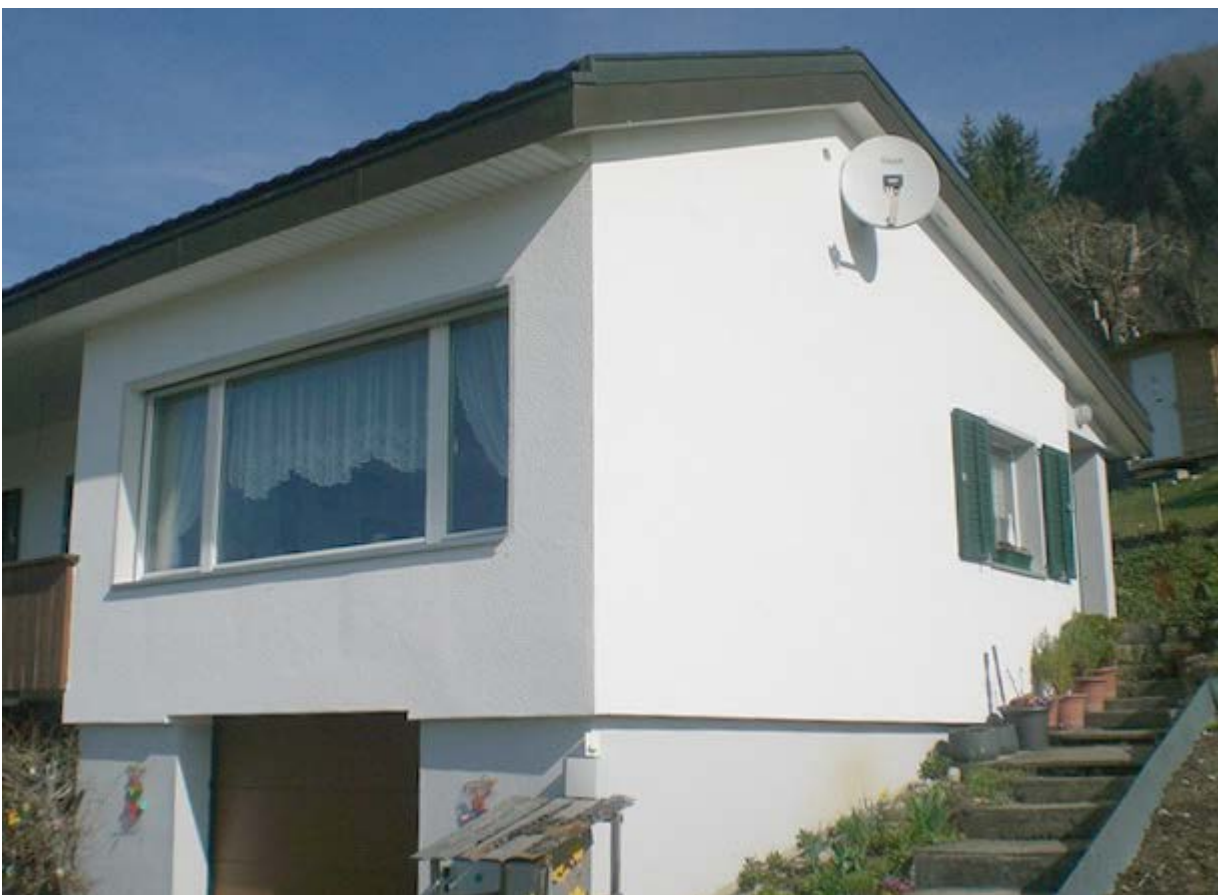
EFH Frei, Süd- und Ostfassade
