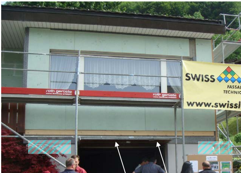
Figur 15: Südfassade mit teilweise montierten Platten 28.5.2008. Nachträglich angebrachte unterste Reihe mit teils überdeckender Schraffur angedeutet. Weiter sind die Stösse der Hartplatte sichtbar, die das VIP schützen.
