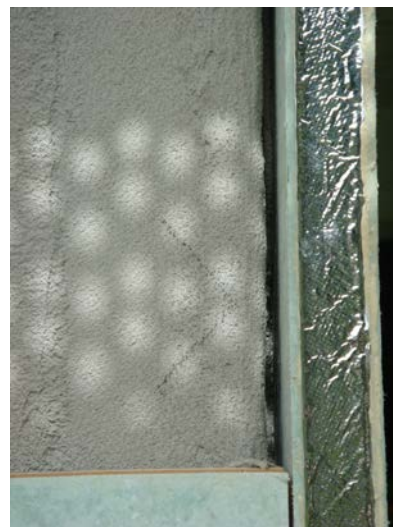
Figur 2: Gleicher Plattentyp wie Fig.1 mit entfernter seitlichem Randschutz, wodurch die silbrige VIP-Hülle sichtbar wird.
